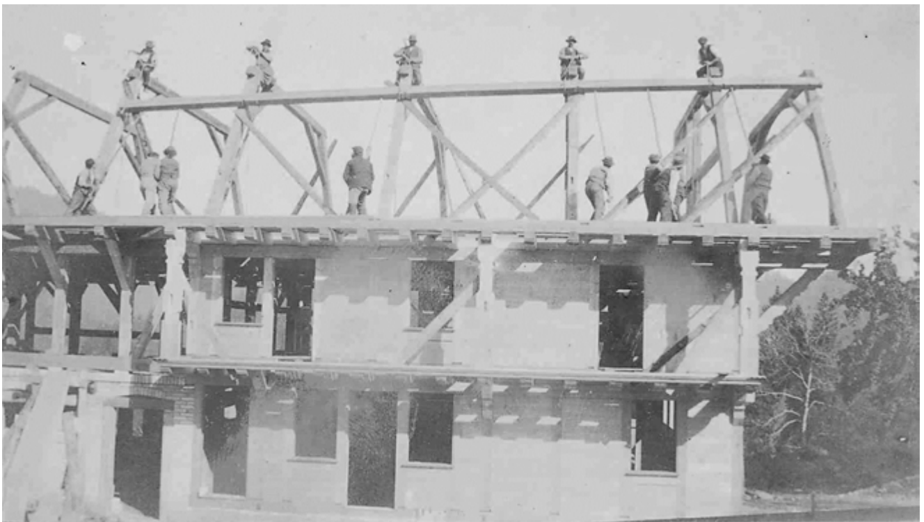
Neubau des Bauernhauses Nr. 36F im Jahr 1922. Aufrichte des neuen Bauernhauses
