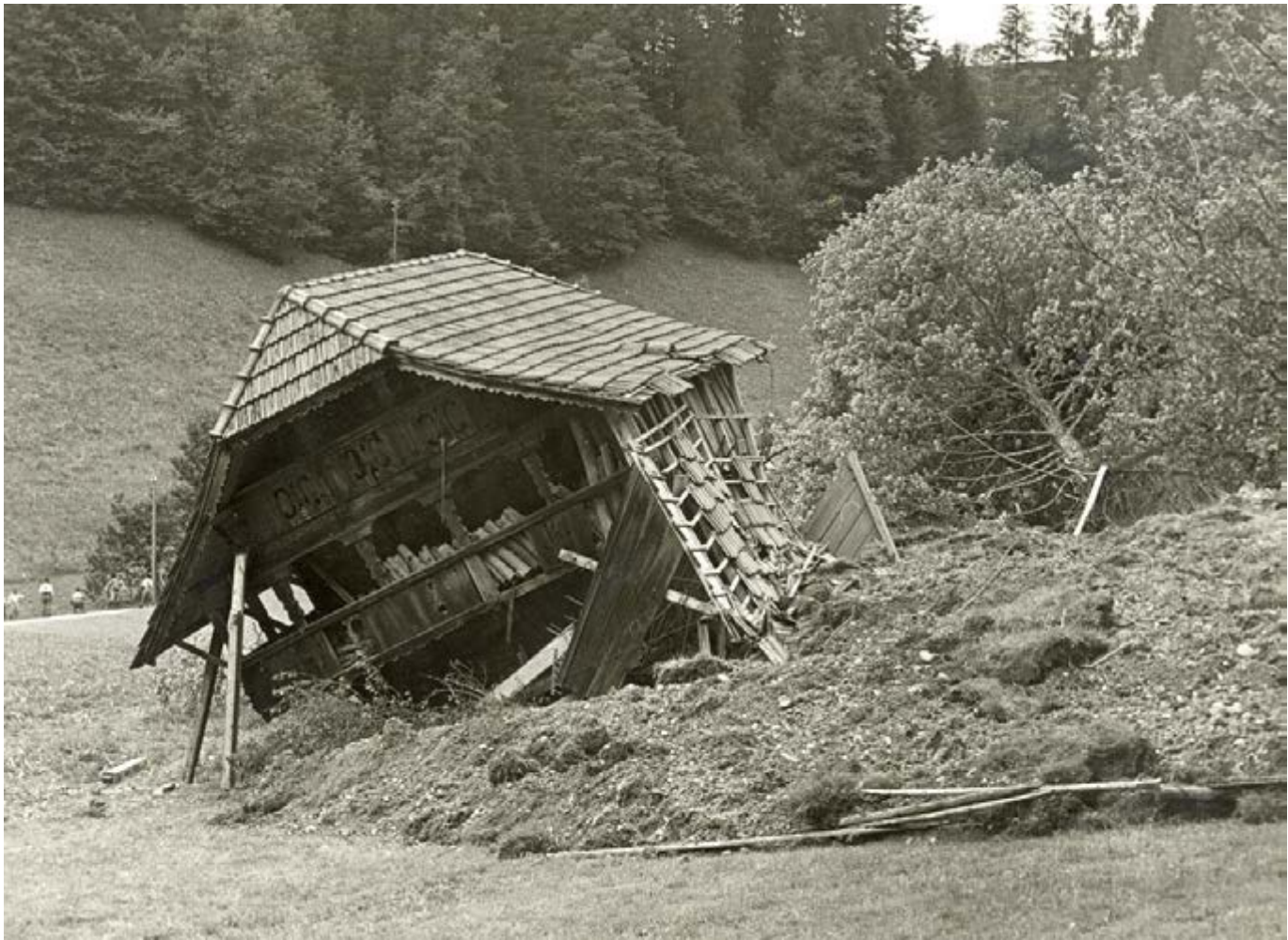
Der Speicher in der Hinter Ey, einige Tage nach dem Unwetter, verschoben und schräg.
